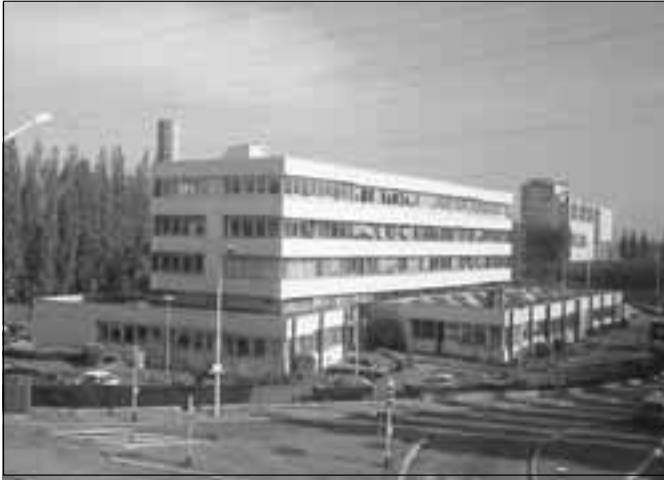
Head Office - Rosny sous Bois
